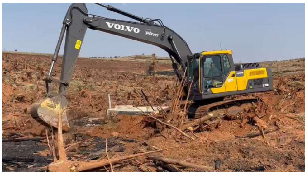
Figura 04 – Escavadeira Hidráulica VOLVO EC200D
