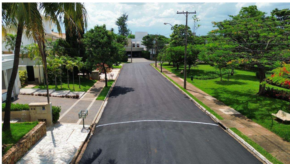
Imagem 9 – Obra de São José do Rio Preto/SP
