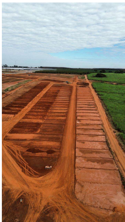
Imagem 12 – Obra de Mirassol/SP
