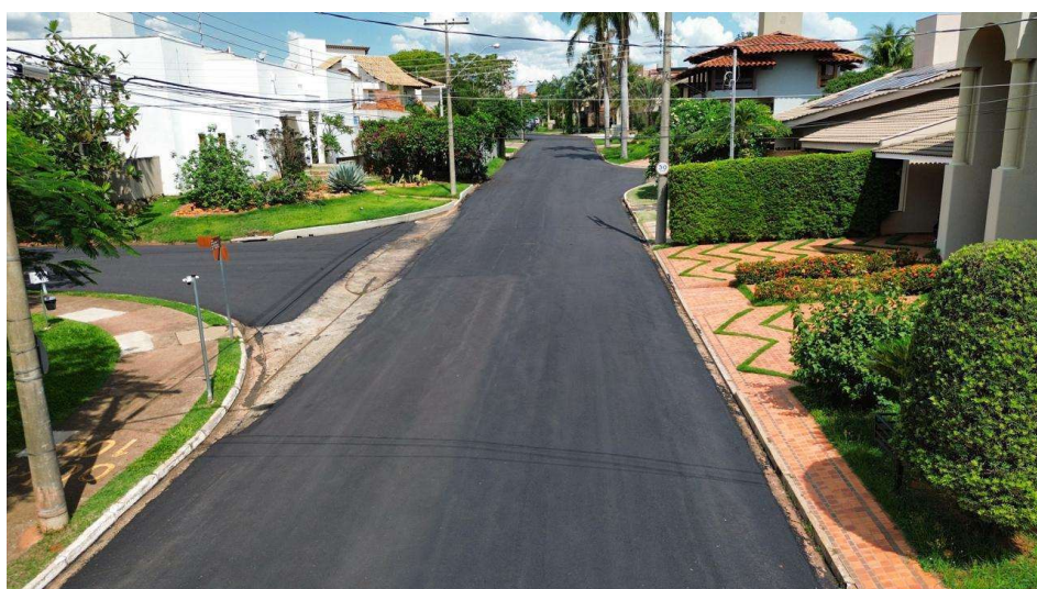
Imagem 10 – Obra de São José do Rio Preto/SP
