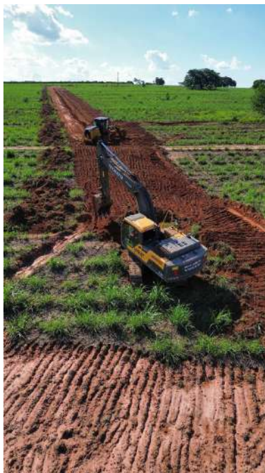
Figura 01 – Escavadeira Hidráulica VOLVO EC200D
