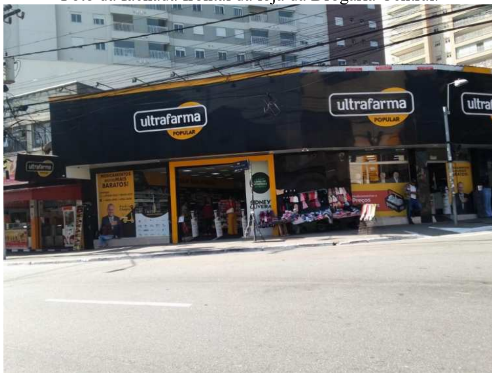
Foto da fachada frontal da loja da Drogaria Central.
