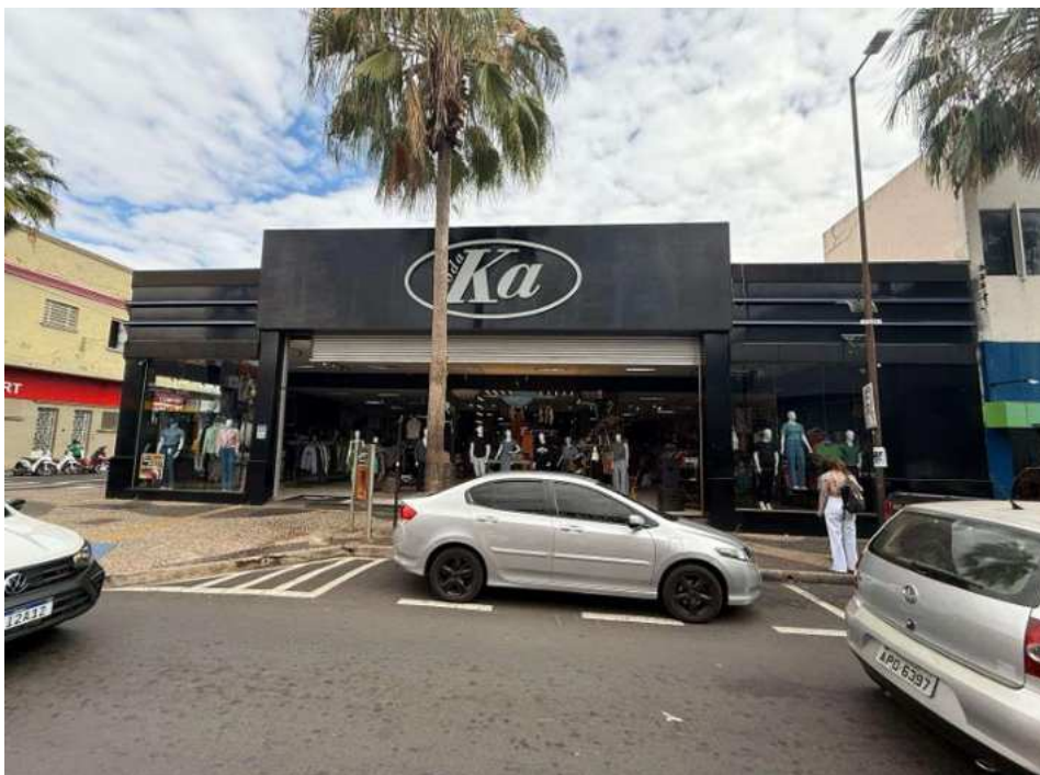
Foto 009: J M De Faria - Fachada
